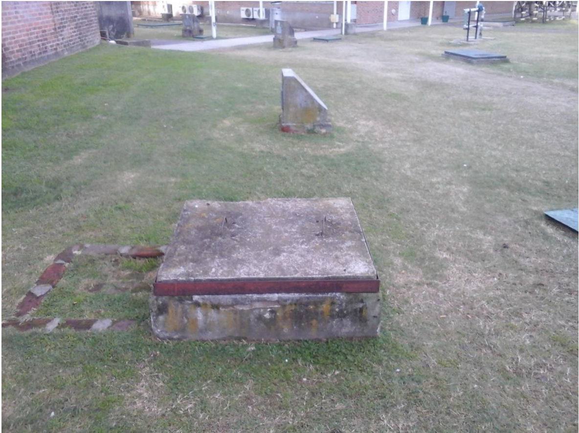
Foto 12: Pozo de extracción cegado. Febrero 2014
