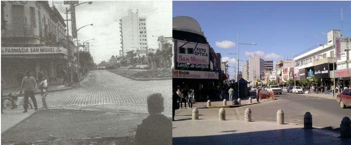
Foto 6: Comparación de las transformaciones del eje de la Av. Pte. Perón (ex León Gallardo): a la izquierda en durante la década de 1970, cuando se procede a la demolición de su bulevar y el ensanche vial; a la derecha en 2013 con posterioridad a las obras de remodelación para la concreción del Paseo Comercial a Cielo Abierto. Fuente: sitio web de San Miguel en fotos ( www.sanmiguelenfotos.com.ar ).
