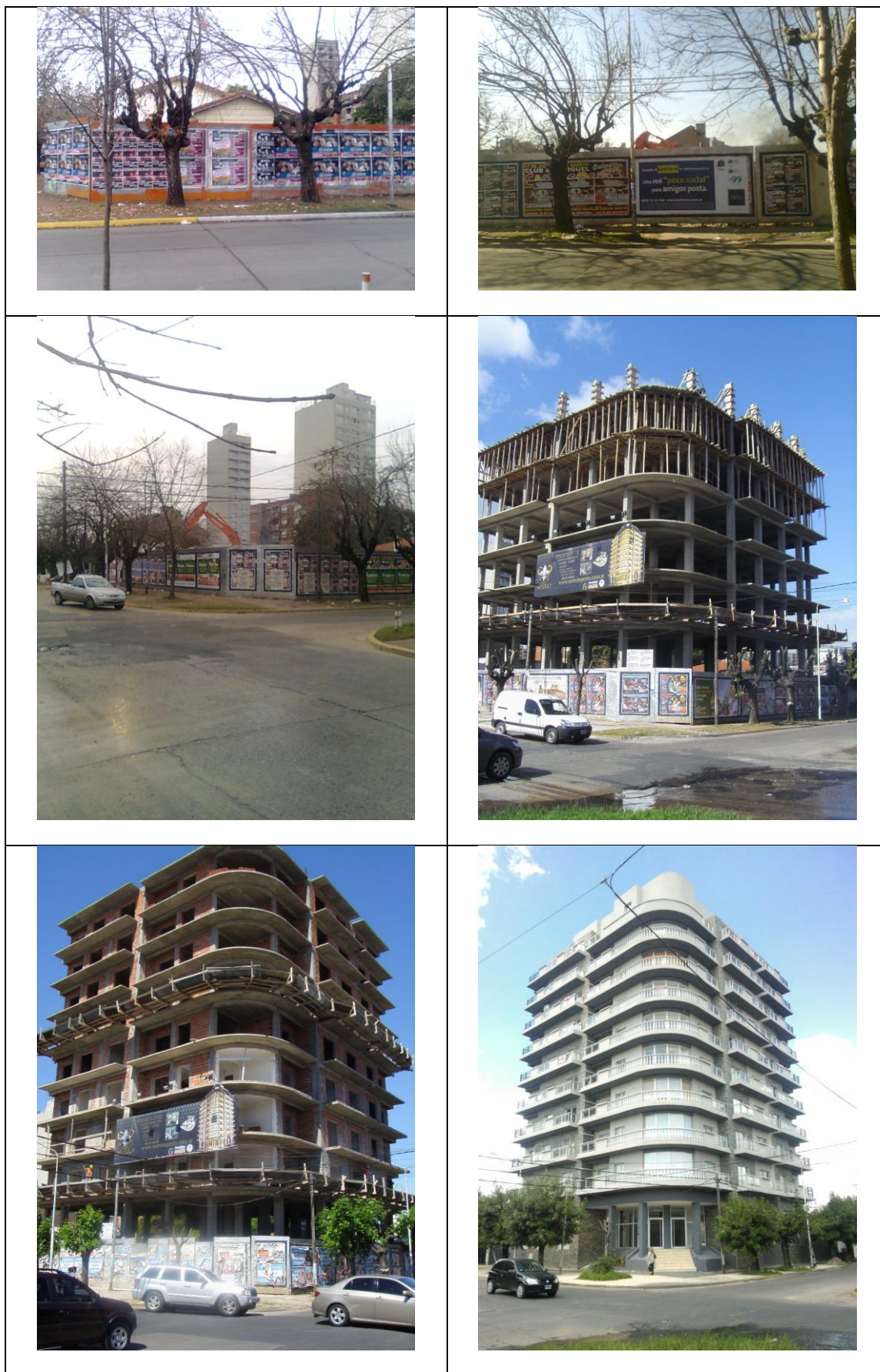
Foto 8: Verticalización edilicia de una parcela dentro de la zona Microcentro de San Miguel (vivienda unifamiliar a vivienda multifamiliar). Fuente: Fotografías propias (agosto 2010 a marzo 2013).
